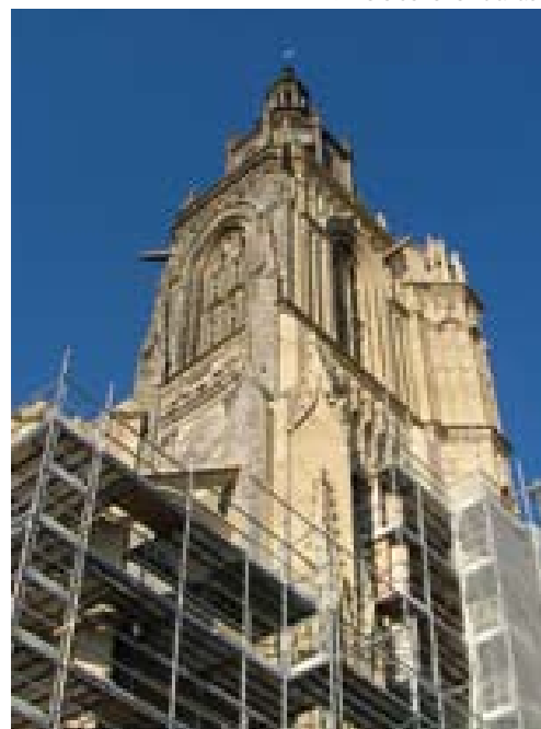
> Le clocher en travaux
