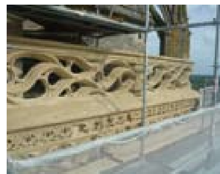
> Balustrade après restauration
